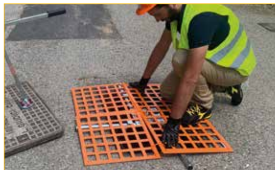
Grata metallica auto centrante e pieghevole. Può sostenere senza deformarsi un peso di oltre Kg 200.
